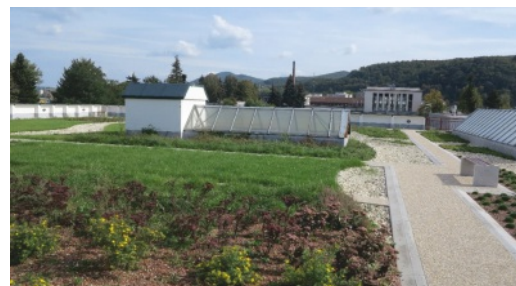
Vegetačná strecha Vegetačná strecha autobusovej stanice, Zvolen
